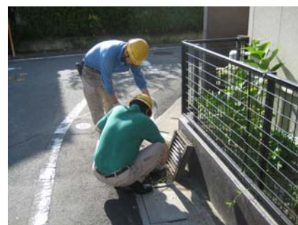
十四山工場 外周の公共道路
