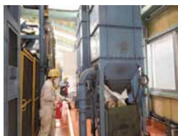
④消火器による消火（スラグ）
