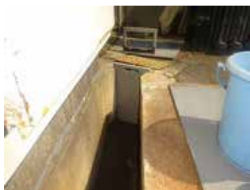
① 遮蔽版の取付け訓練
