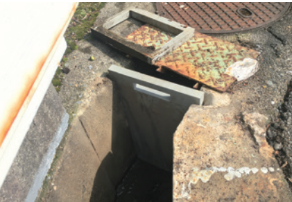
① 遮蔽板の取付け訓練
