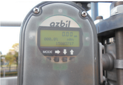
⑥ 流量計により流出停止を確認
