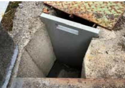
① 遮蔽板の取付け訓練
