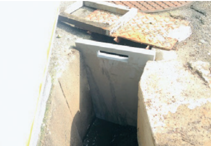
① 遮蔽板の取付け訓練
